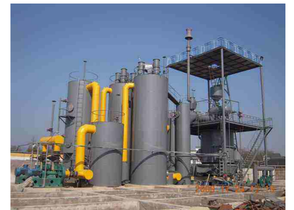
煤气发生炉现场
